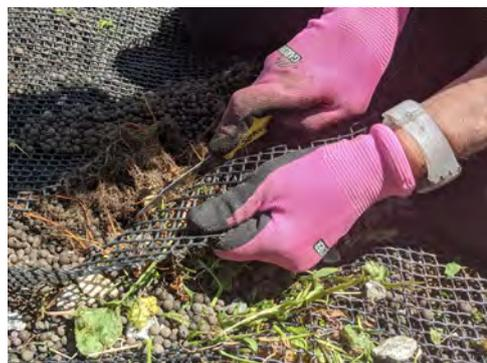
Schnell war klar, dass es mit „Unkrautjäten“ nicht getan war. Die komplette Kiesauflage musste entfernt werden, die darunterliegenden Bahnen der Gitterfolie mussten aufgehoben werden, um die riesigen Wurzelgeflechte entfernen zu können. Diese waren teilweise so mit der Gitterfolie verwurzelt, dass wir sie mühsam mit dem Filetirmesser von der Folie trennen mussten.
